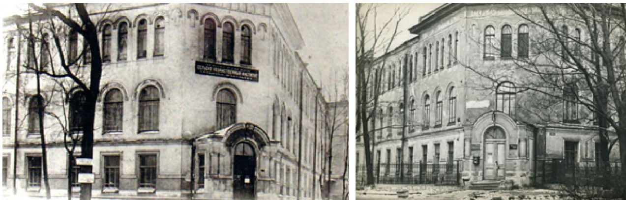
Рис. 5. Здание «Сельско-хозяйственного института» на Каменном острове (слева), переданное институту онкологии (справа) Fig. 5. The building of the Agricultural Institute on Kamenny Island (left) transferred to the Institute of Oncology (right)
